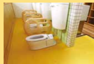
大阪市住吉区 ひまわり保育園様 トイレ乾式工事
