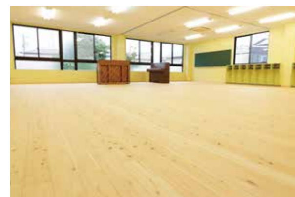
箕面市 認定子ども園牧落幼稚園様 1階 2階改修工事/床
